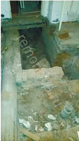
Демонтаж пола в комнате 20 м 2 старого дома – 7 000 руб. Демонтаж старого основания и подсыпка ПГС – 8 700 руб.
